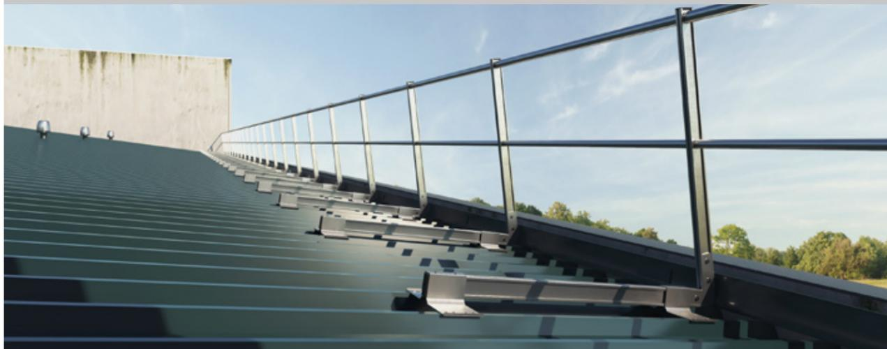
Parapetto LIMIT su copertura metallica a volta
